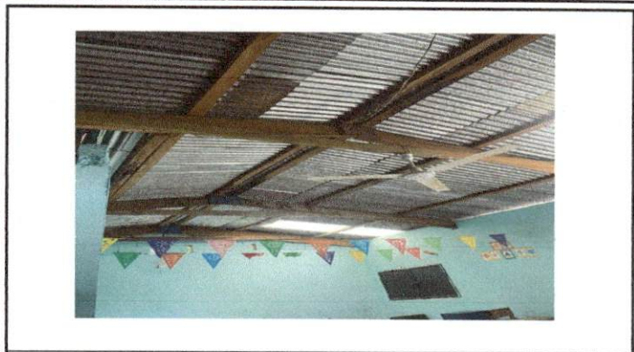
Foto 2: Cambio de techado del aula numero 8 por deterioro.
