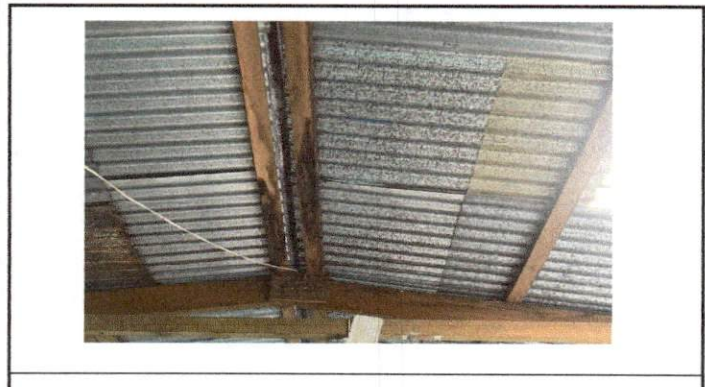
Foto 5: cambio de techado del aula número 9
